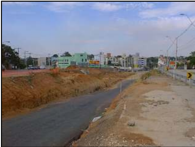
Figura 20: Demolições referentes à III Perimetral.
