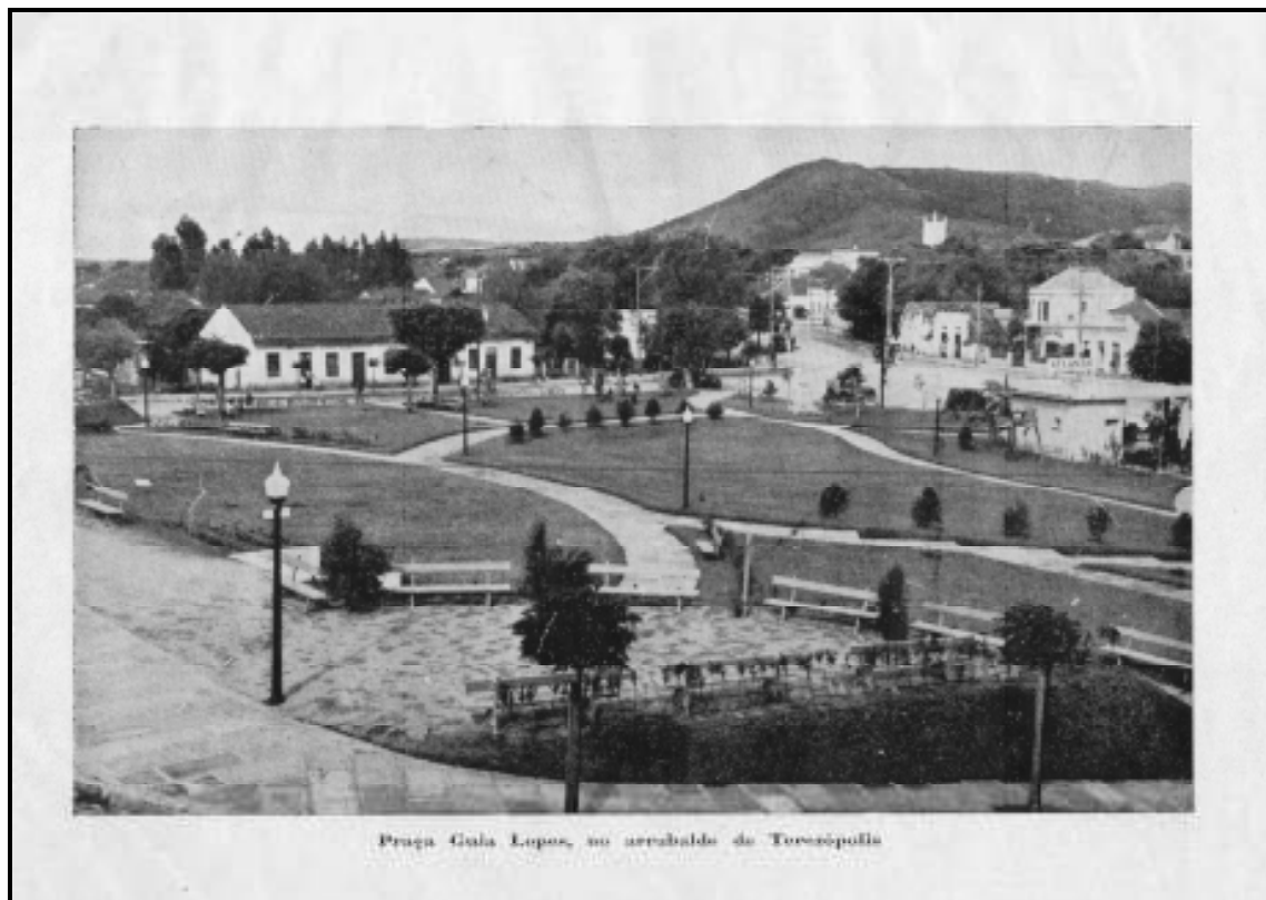
Figura 5: Vista da Praça da igreja, na década de 20.
