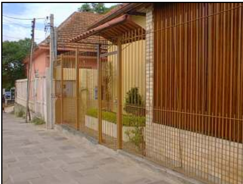
Figura 21: Edificação junto à avenida, com resquício de recuo de jardim.
