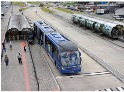
Figura 5 - sistema BRT em Curitiba.
