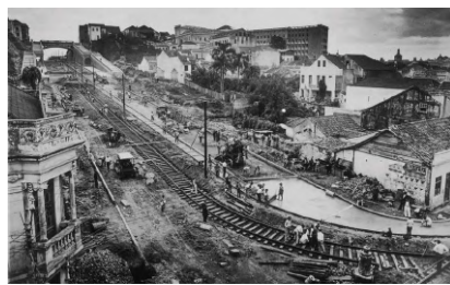
Figura 10 - construção do Vd. Otávio Rocha.
