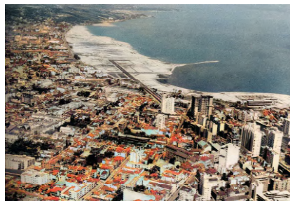
Figura 25: Aterro Praia de Belas em execução.
