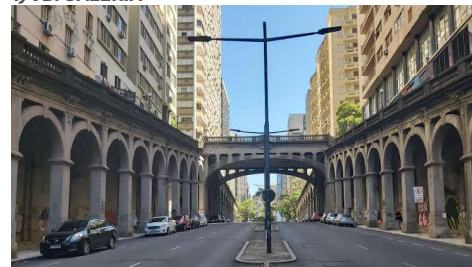
Viaduto Otávio Rocha (1932).
