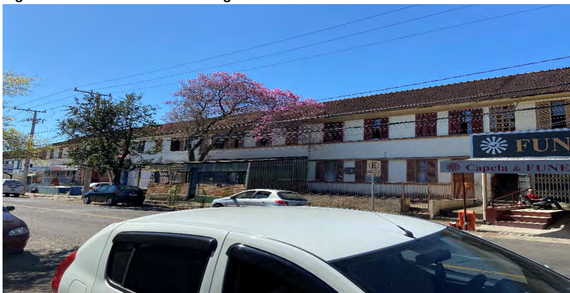
Figura 8: IAPI em Novo Hamburgo
