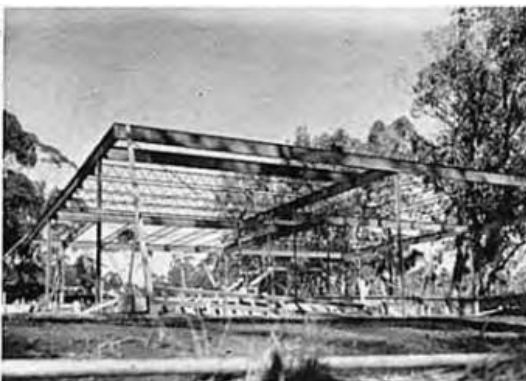
Figura 49 | Estrutura metálica Casa Entenza. Fonte: http://www.artsandarchitecture.com/case.houses/pdf01/09.pdf - Acesso em: 03 mar 2022
