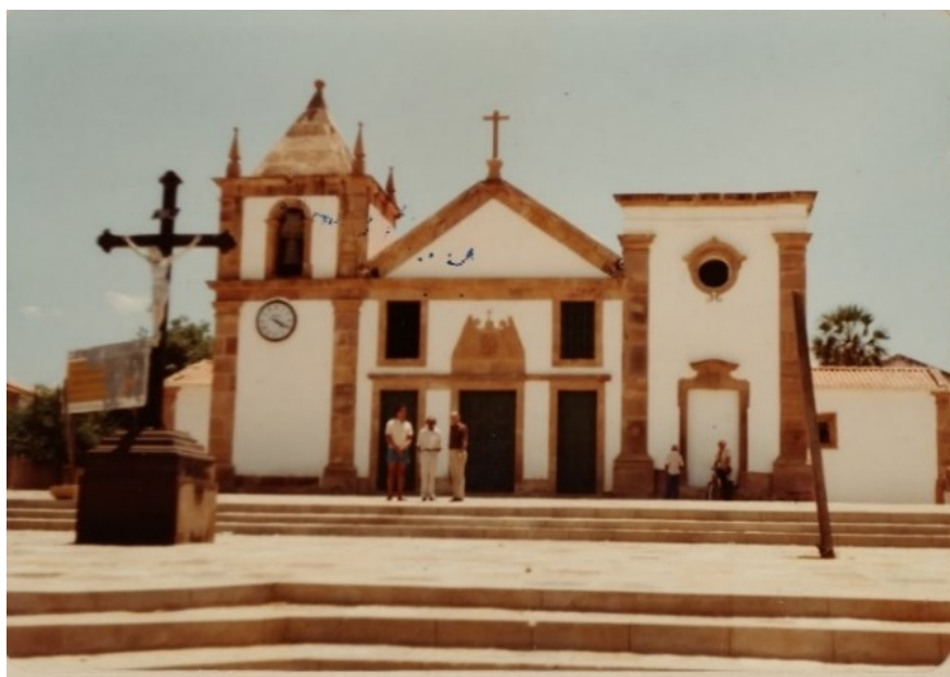
Figura 60: Igreja Nossa Senhora da Vitória durante restauração pelo PCH Fonte: Arquivo Central do IPHAN- RJ
