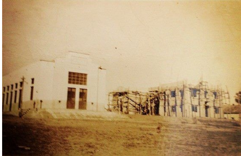
Figura 10: Cineteatro à esquerda e à direita, sede da Associação Comercial ainda em construção Fonte: Fundação Nogueira Tapety
