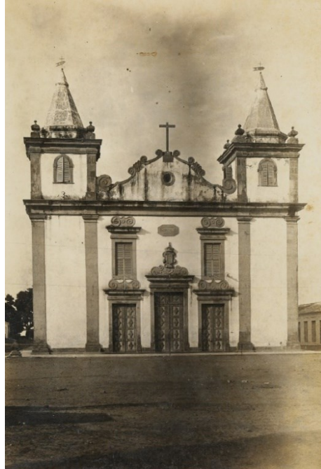
Figura 23: Igreja Nossa Senhora do Carmo de Piracuruca- PI, tombada em 1940 Fonte: Arquivo Central do IPHAN- RJ
