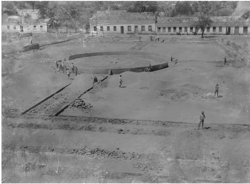
Figura 11: largo da matriz na terraplanagem fonte: Fundação Nogueira Tapety
