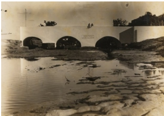
Figura 26: Ponte após os reparos Fonte: Arquivo Central do IPHAN- RJ
