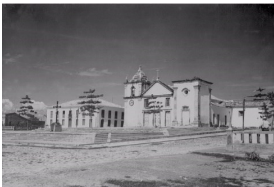
Figura 102: Igreja N. S. Da Vitória em 1957 FONTE: IBGE
