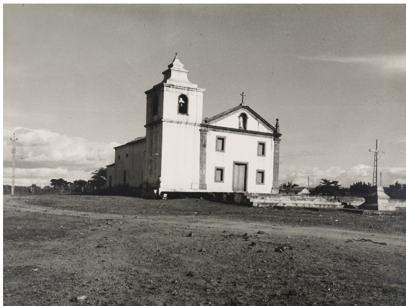
Figura 63: Igreja Nossa Senhora do Rosário Fonte: Acervo Arquivo Central do IPHAN - RJ
