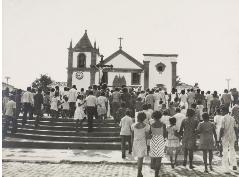
Figura 33: Igreja Nossa Senhora da Vitória – janeiro/ agosto 1976. Fonte: Acervo Central do IPHAN
