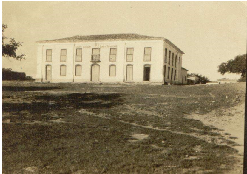
Figura 28: Palácio João Nepomuceno em 1938 na ocasião de identificação Fonte: Arquivo Central do IPHAN - RJ
