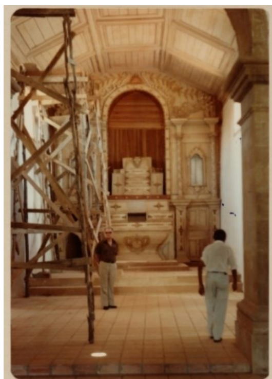
Figura 61: Interior da Igreja Nossa Senhora da Vitória durante a restauração Fonte: Arquivo Central do IPHAN- RJ
