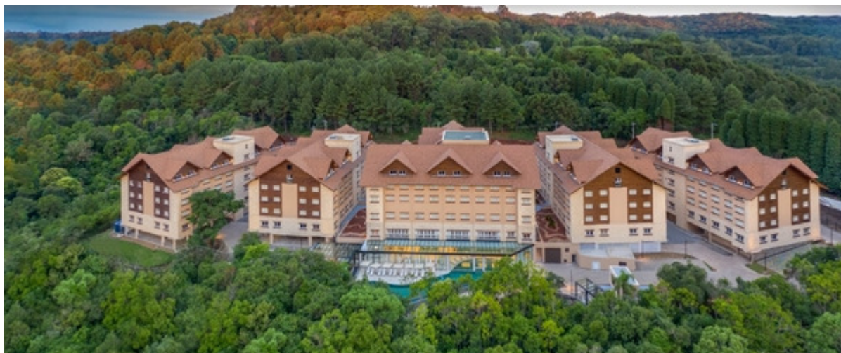
Figura 37 – Grandes empreendimentos imobiliários na zona rural
