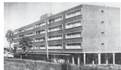
98 Román Fresnedo Siri, Conjunto Habitacional Cerro Sur, Montevideó, 1950.
