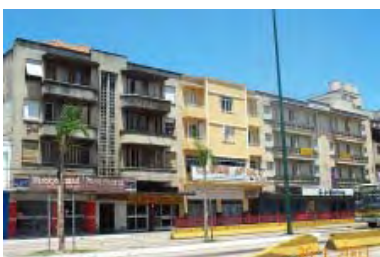
2 Av. Farrapos, edifícios de apartamentos, Porto Alegre, década de 40.
