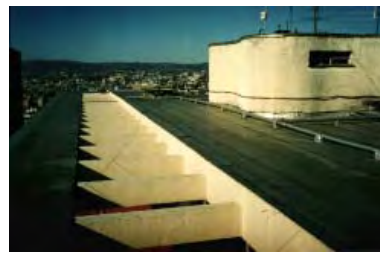
92 Román Andrés Fresnedo Siri, Ed. Esplanada, Porto Alegre, 1952, Vista da cobertura.
