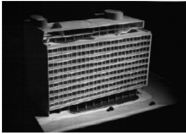
28 Ed. da Viação Férrea do RS, Porto Alegre, 1944, Arq. (s) Jorge Machado Moreira e Afonso Eduardo Reidy
