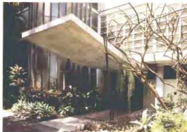
70 Lúcio Costa, Parque Guinle, Ed. Nova Cintra, 1948-54, marquise de acesso.
