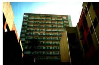
90 Román Andrés Fresnedo Siri, Ed. Esplanada, Porto Alegre, 1952, P. Baixa Casa Máquina / Reservatório.
