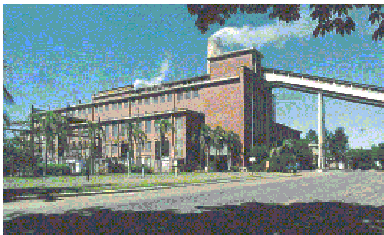
Figura 3 - Unidade Termoelétrica Charqueadas, Charqueadas, RS.
