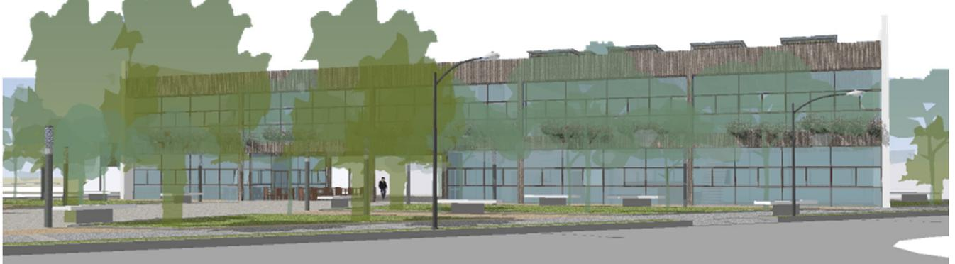
Edificação em 2 pavimentos com formato em I com a quina arredondada. O volume da escada se destaca na face arredondada do prédio. Parte em pilotis dá permeabilidade para a praça onde o edifício é situado.
